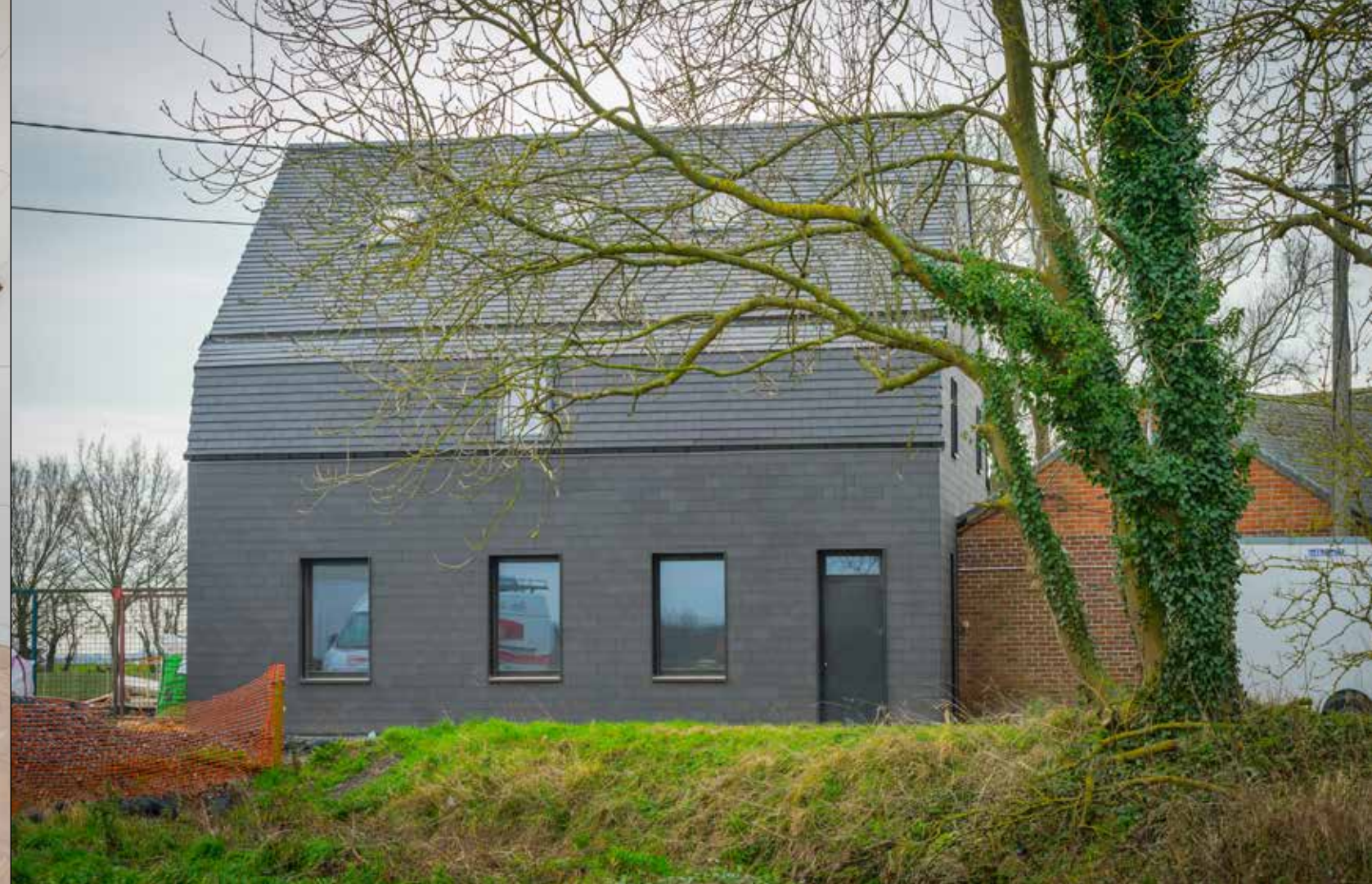
• Isolatie dak: Powerroof® 2 x 100 mm • Isolatie gevel: Powerwall® 2 x 100 mm • Aannemer gevel- en dakwerken: Tom Stockman, Kortrijk • Bouwheer en architecte: Cyndie Hanssens
